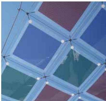
BELECTRIC OPV. Solarmodule in verschiedenen Farben als Verschattungselemente Solar modules in various colors as shading elements
