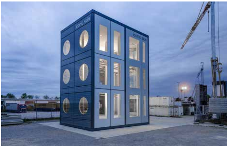
Das Maximalformat des iconic skin Elements ist 3,20m breit und 15m hoch. The maximum size of the iconic skin element is 3.20 m wide x 15 m high.
