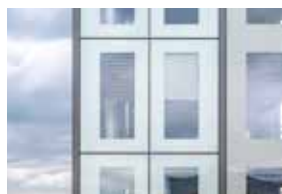
Sonnen- und Blendschutz werden im Scheibenzwischenraum integriert.
