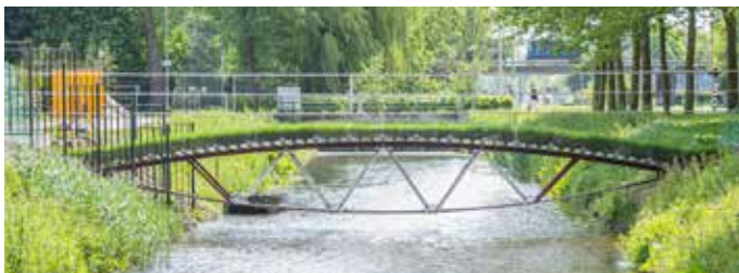
Glasfachwerkbrücke auf dem Campus der TU Delft Glass Truss Bridge at TU Delft campus
