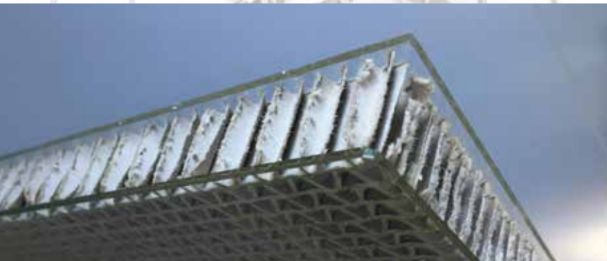
Abb. 8: Konzeptionelles Design eines Besucherpavillons aus zweifach gekrümmten Dünnglas-Papier-Verbundträgern (ISMD, TU Darmstadt, glasstec 2018)
