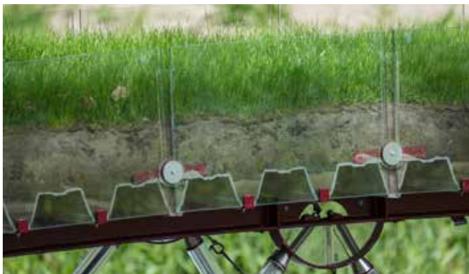
Detail der Glasfachwerkbrücke Detail of Glass Truss Bridge
