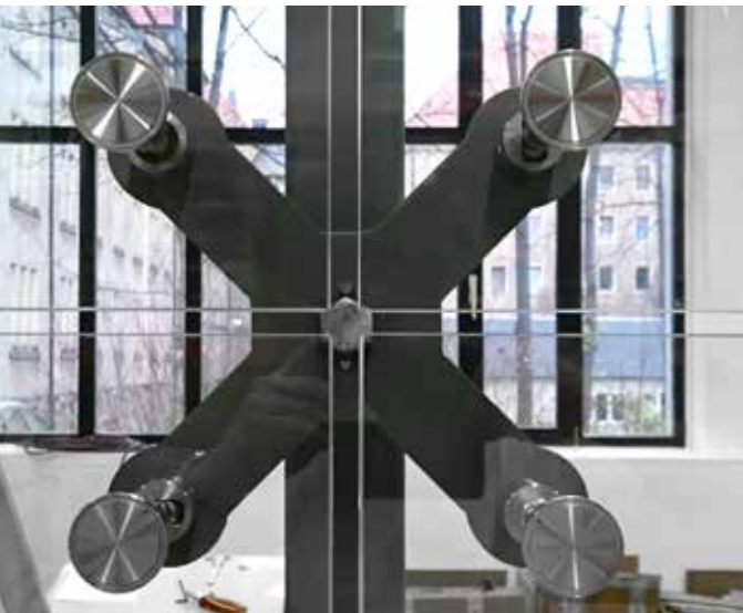
Punkt förmig transparente Klebung (© Jan Wunsch) Punctual, transparent bonding (© Jan Wunsch)
